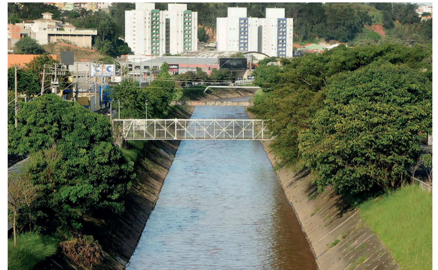
Jundiaí é cidade exemplo no tratamento de esgoto e saneamento básico
