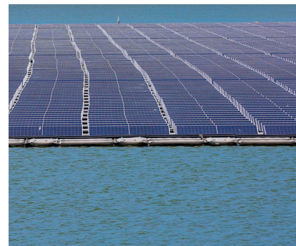
A princípio, foram instaladas 10,5mil placas solares na Billings
